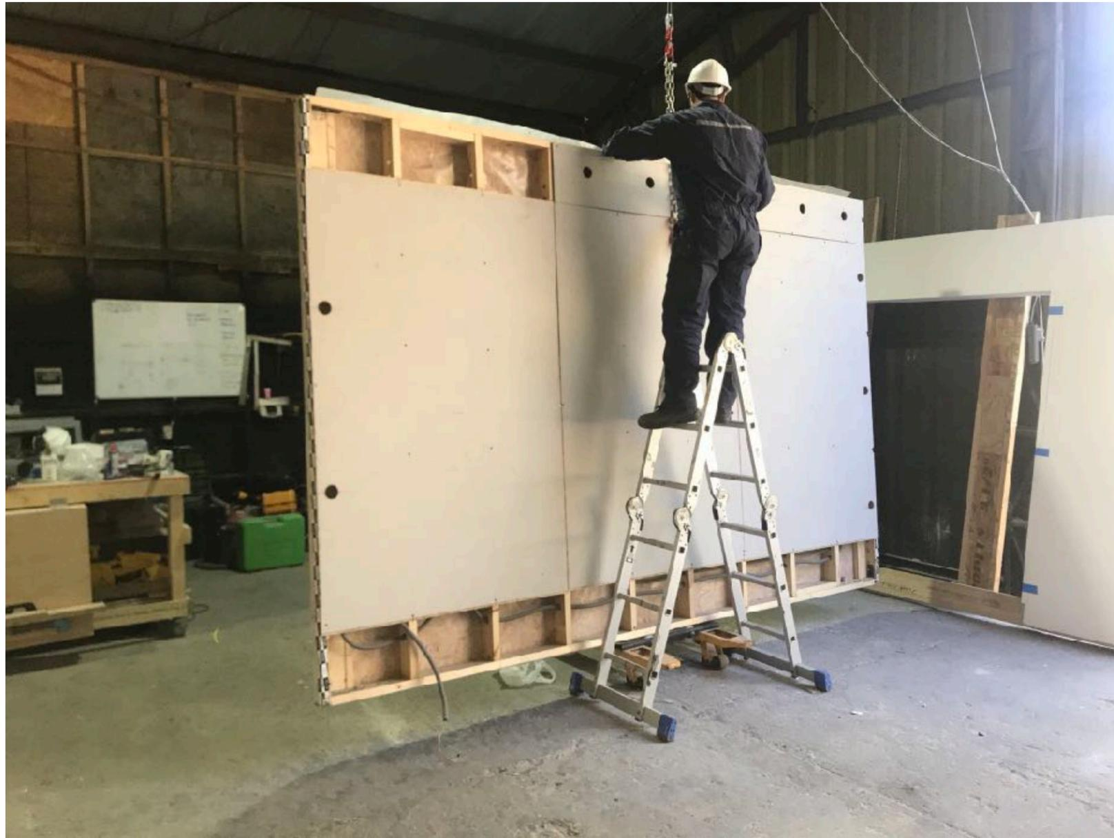
IMG1: NUESTROS TABIQUES MANTIENEN TODAS SUS CONEXIONES ESTRUCTURALES Y DE SISTEMAS , CON EL FIN DE AGILIZAR LOS PROCESOS DE ABRA Y DISMINUIR LAS PERDIDAS RELACIONADAS CON EL DESARROLLO EN OBRA
